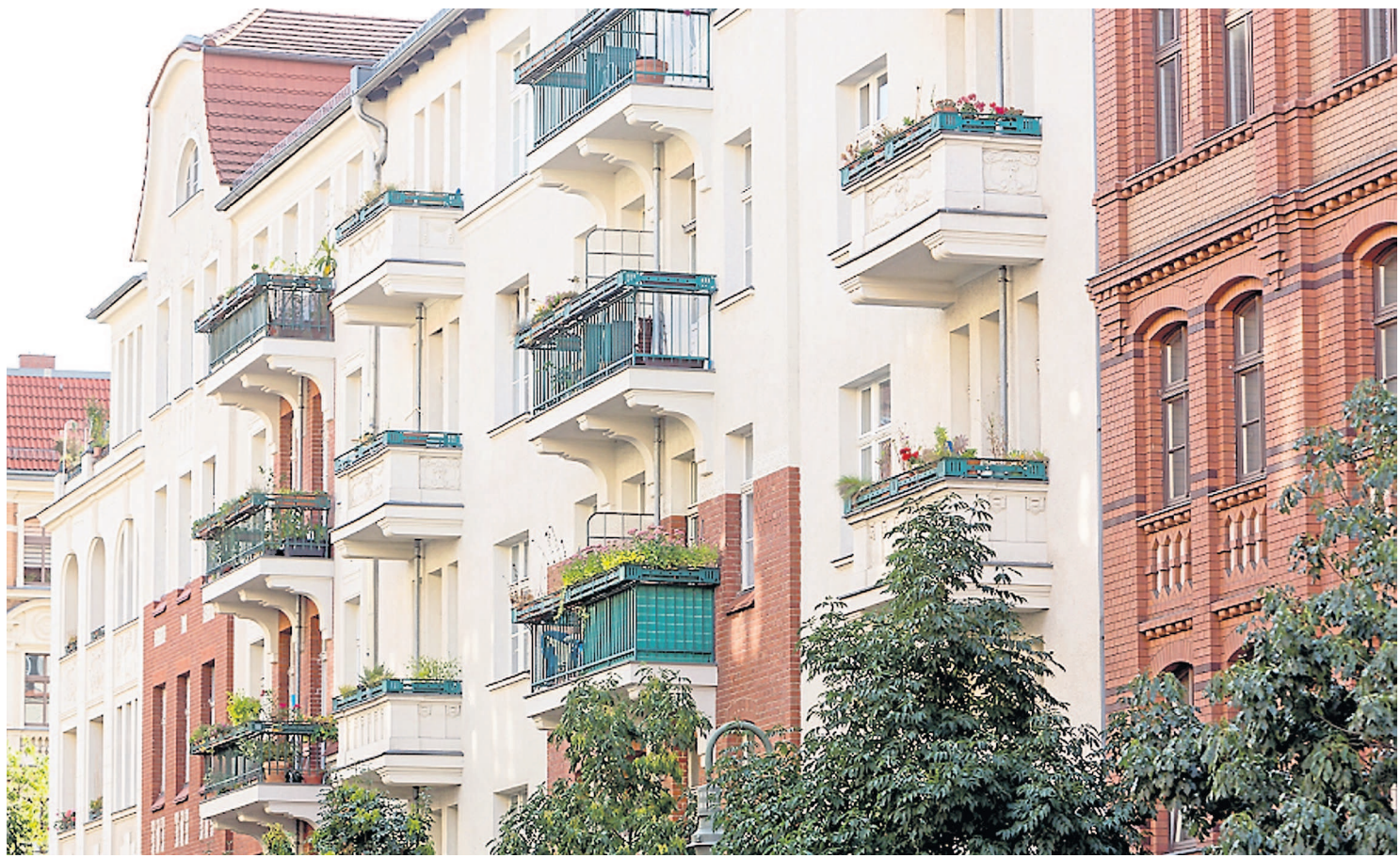
Hier wird energiesparend und umweltschonend geheizt: die Wohnungsbaugenossenschaft Bremer Höhe.
