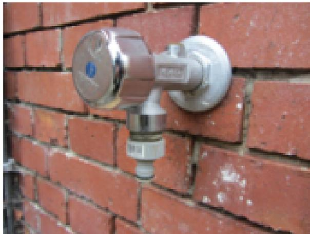
Außenwasserhähne sind so konstruiert, das Sie nach dem Zudrehen nachlaufen, um ein Einfrieren des Wasser im Zulaufrohr zu vermeiden.
