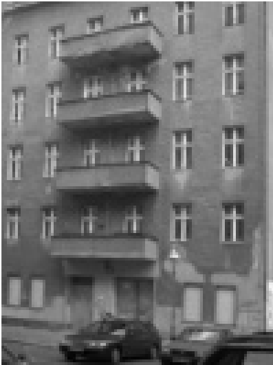
Die Straßenfront des noch unsanierten Hauses in der Katzlerstraße.
