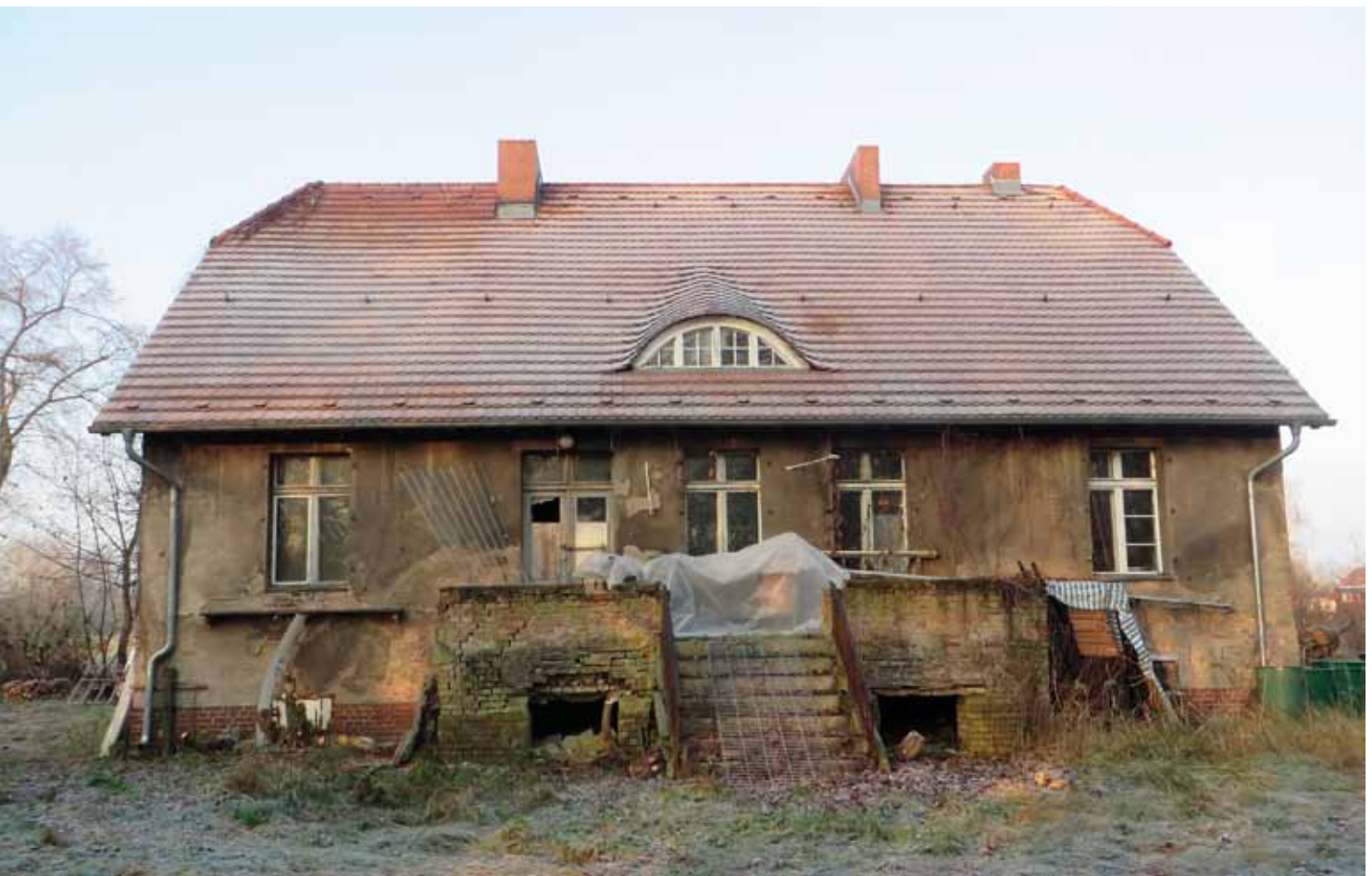
– Ehemaliges Inspektorenhaus Hobrechtsfelde
