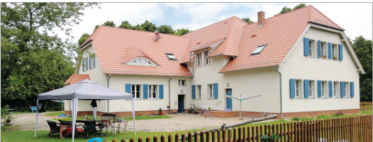
das in 2011 /12 sanierte und umgebaute ehemalige Arbeiterwohnheim in Hobrechtsfelde
