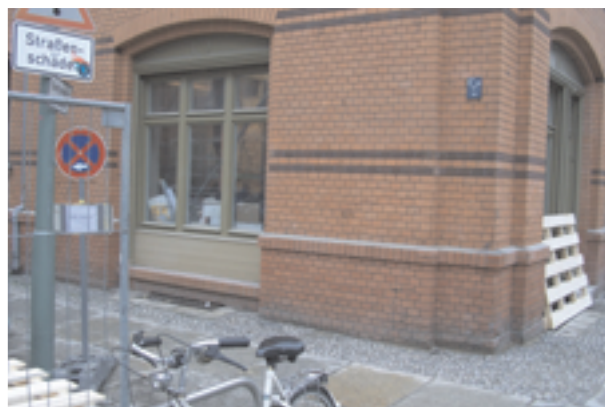
Noch wird am neuen Gemeinschaftsraum fleißig gebaut.
