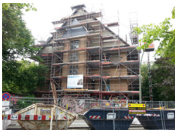
Die eingerüstete Nordfassade des Georg-von-Rauch-Hauses.
