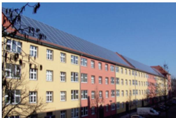
Die Photovoltaikanlage auf dem nach Süden ausgerichteten Schrägdach der Bornitzstraße hat eine Fläche von ca. 1.000 m<sup>2</sup>.
