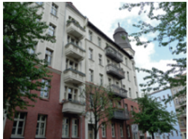
Alte sanierte Balkone neben neuen Balkonen stellen einen Kompromiss mit der Denkmalpflege dar.
