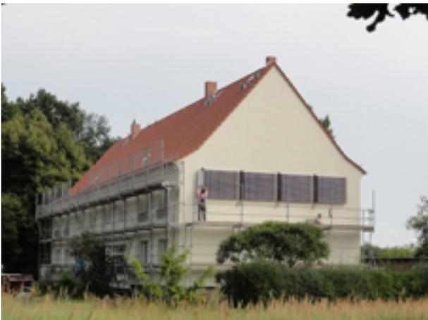
Die Sanierung des Hauses Dorfstraße 1-2 ist weit vorangeschritten. Am Giebel befinden sich solarthermische Paneele.
