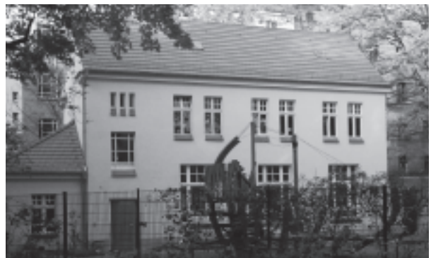
Der Kindergartens 1938 und nach der Sanierung im Jahre 2005
