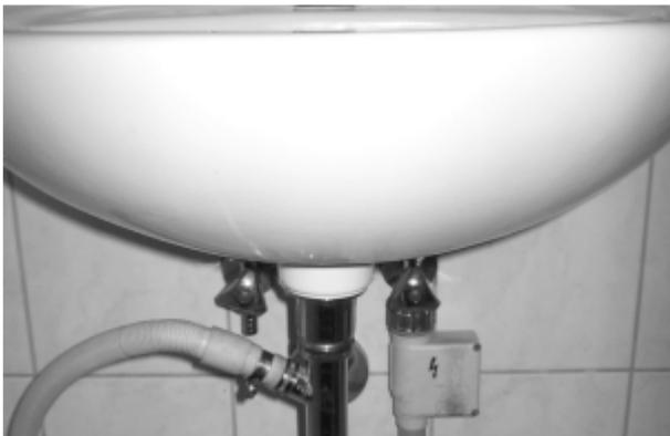
Prinzipiell muss die Waschmaschine am Kaltwasseranschluss angeschlossen werden.
