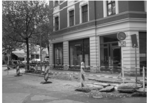
Endlich: Gehwegsanierung vor der Buchholzer Straße 22a im September 2007.
