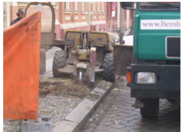
Mit der Stubbenfräse werden, wie hier vor der Gneiststraße 6, die Baumstubben nach der Fällung ausgefräst. Die BIRDS setzt sich für Neupflanzungen an diesen Stellen ein.
